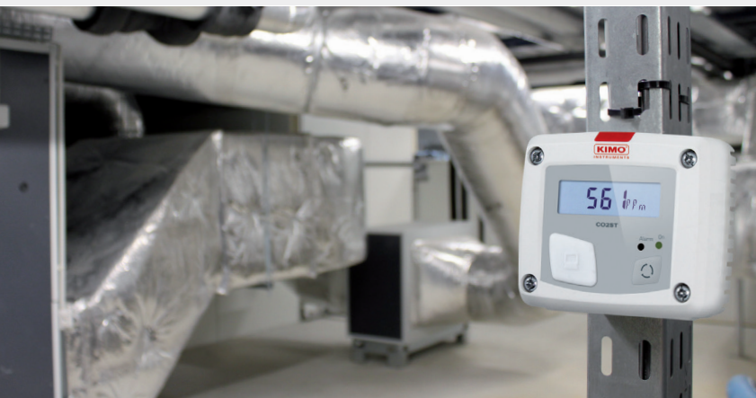
CO2ST installato nell'unità di trattamento aria di un'infrastruttura industriale.
