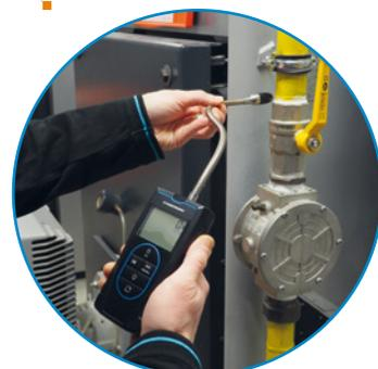
DÉTECTION DE FUIE DE GAZ COMBUSTIBLE EN AMONT DU BRÛLEUR D'UNE CHAUDIÈRE
