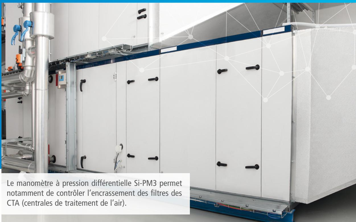
Le manomètre à pression différentielle Si-PM3 permet notamment de contrôler l'encrassement des filtres des CTA (centrales de traitement de l'air).
