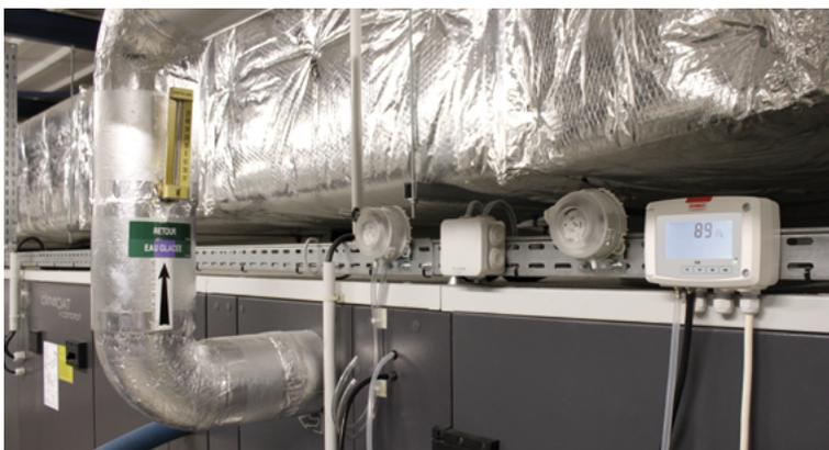
CP210-R in der Lüftungsanlage einer Industrieanlage.
